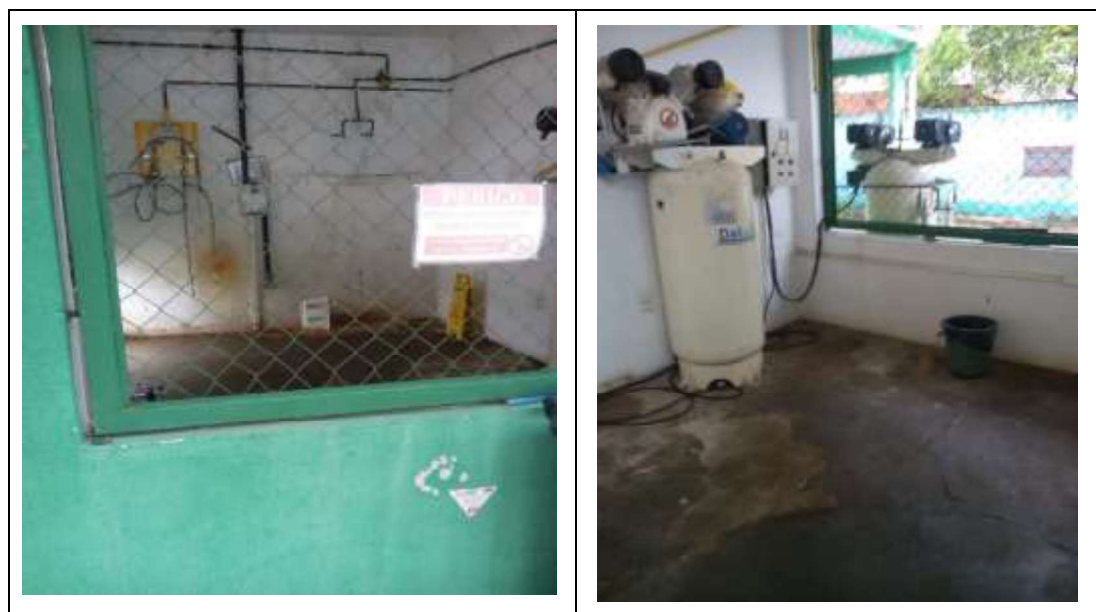
Figura 10: Desinstalação da usina de gases medicinais da LocAr na UPA Jurema
