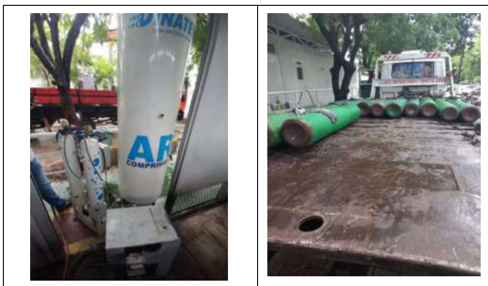
Figura 12: Desinstalação da usina de gases medicinais da LocAr na UPA Centro
